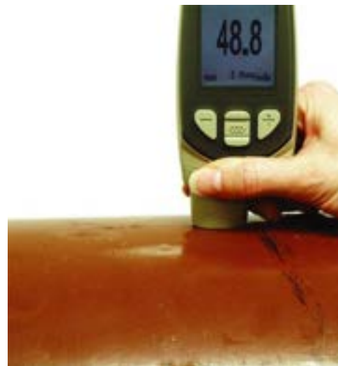
מדידת עובי ציפוי
