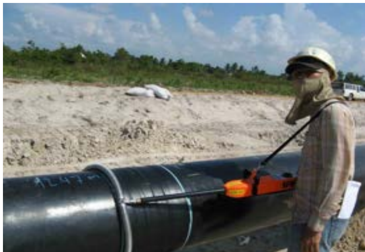
בדיקת רציפות הציפוי (Spark Test)
