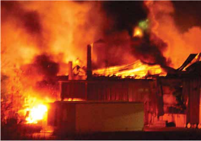
האש שהתפשטה במפעל Hayes Lemmerz International באינדיאנה ארה"ב כתוצאה מסידרת פיצוץי אבקת אלומיניום. סדרת הפיצוץ החלה כתוצאה מפריקת חשמל סטטי בקולט האבק - אבקת האלומיניום היתה טעונה בחשמל סטטי כתוצאה מהשינוע הפניאומטי. באירוע נהרג עובד אחד ושני עובדים נוספים נפצעו קשה.
